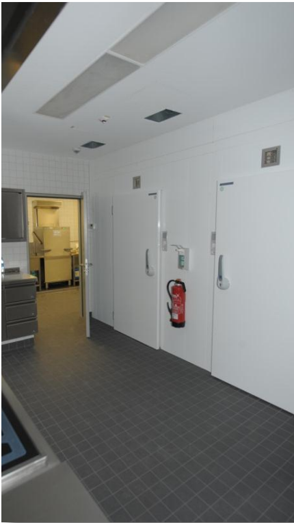
ZUGANG KÜHLRÄUME UND DURCHGANG ZUR SPÜLKÜCHE
